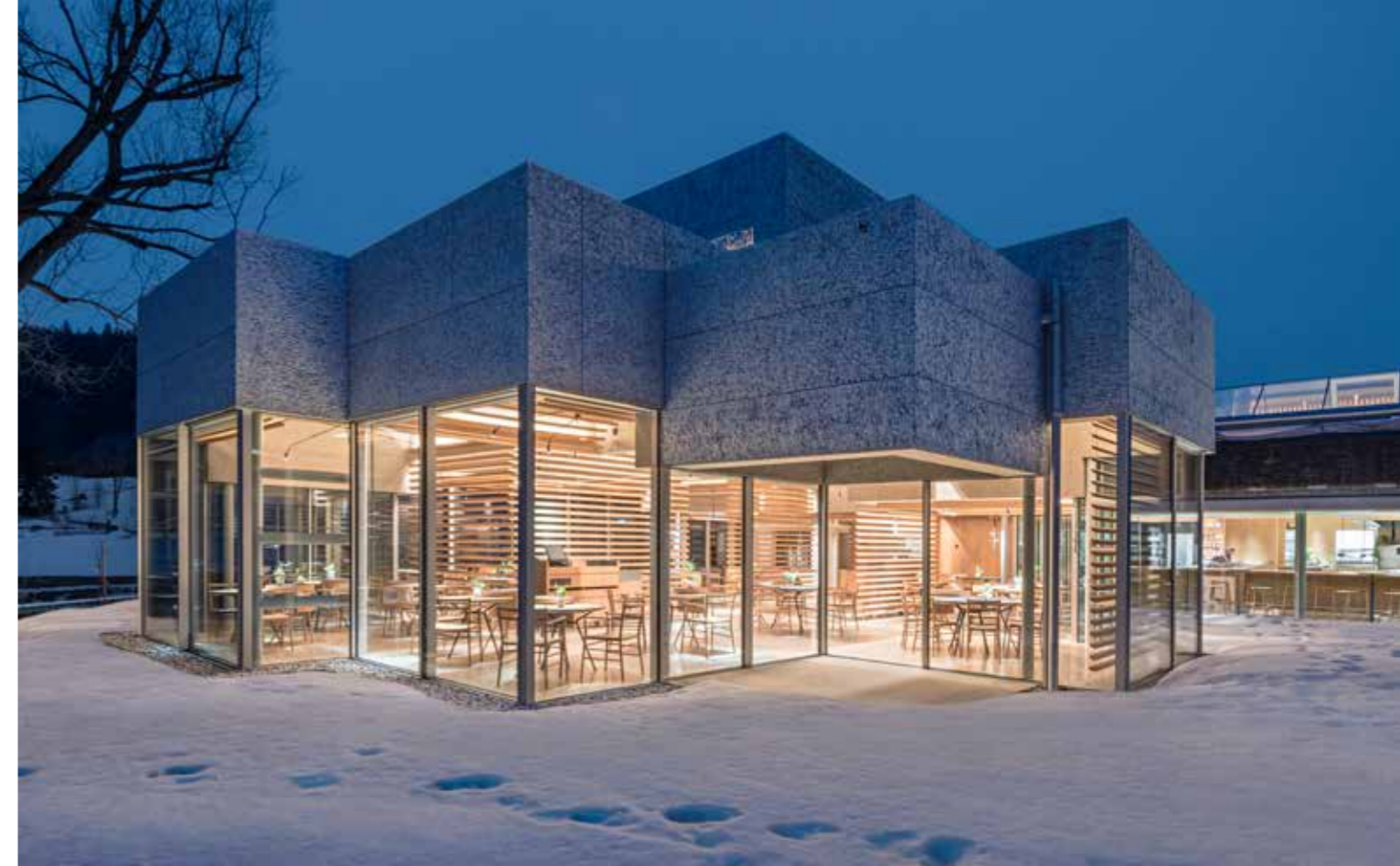
Traditionelle Hüttenoptik im Kontrast mit Moderne aus Aluminium und Glas Alusion™ by Cymat Technologies, AL-FG-12.7-LG-2S (große Zellen beidseitig geöffnet) Projekt: Verglastes Salettl des Wirtshaus Steirereck Pogusch in Turnau (Österreich) mit Schauküche, ,Umsetzung: Alois Perwein GmbH, Fotos: Hertha Hurnaus
